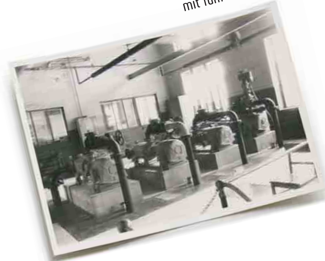
Pumpstation mit fünf Turbinen
